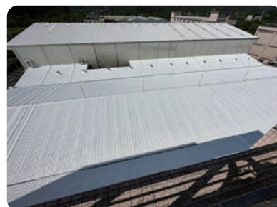
▲屋頂塗上隔熱塗層
